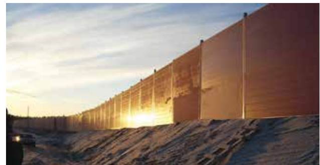
Bullerskärm vid väg E10 mot lossningsstation för järnmalm Svappavaara, Sverige.
