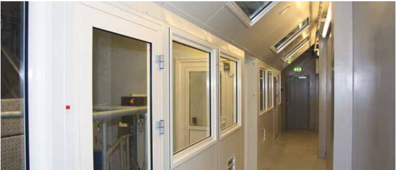
Inkapsling / skiljeväggar produktionsanläggning Novozymes A/S, Bagsvaerd Danmark.
