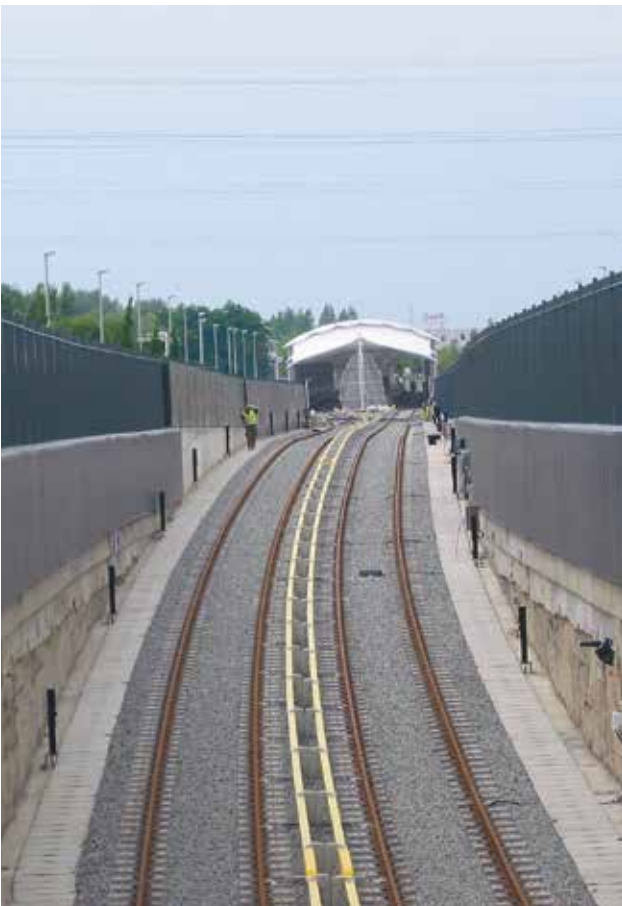
Bullerskärm vid nedfart tunnelbana Bryssel, Belgien.
