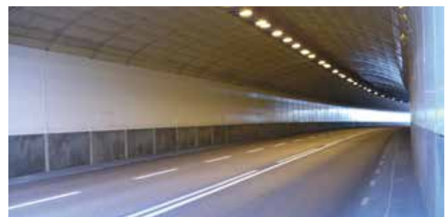
Pulverlackerad bullerskärm Lindötunneln Stockholm, Sverige.
